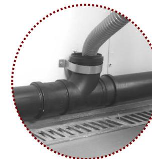
Conectar a mangueira de esgoto no ponto de esgoto destinado a sua instalação.
