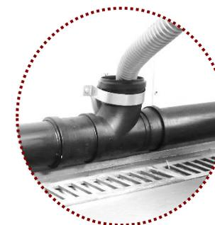
4° Conectar a mangueira de esgoto no ponto de desagüe.
