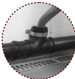
4° Conectar a mangueira de esgoto no ponto de desague.
